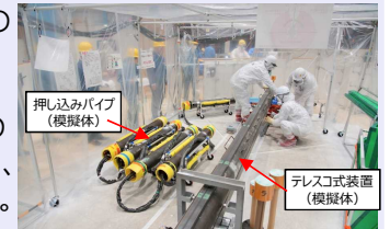
＜模擬環境にて実施した押し込みパイプの作業訓練状況＞
